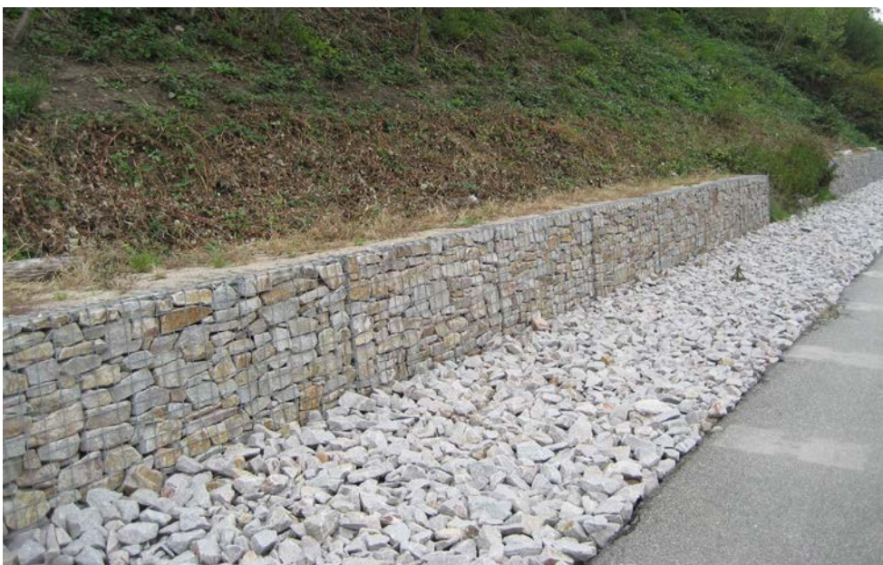
Abb. 18: Gabionen für Mauereidechsen (CEF-Maßnahme), Ostring Karlsruhe
