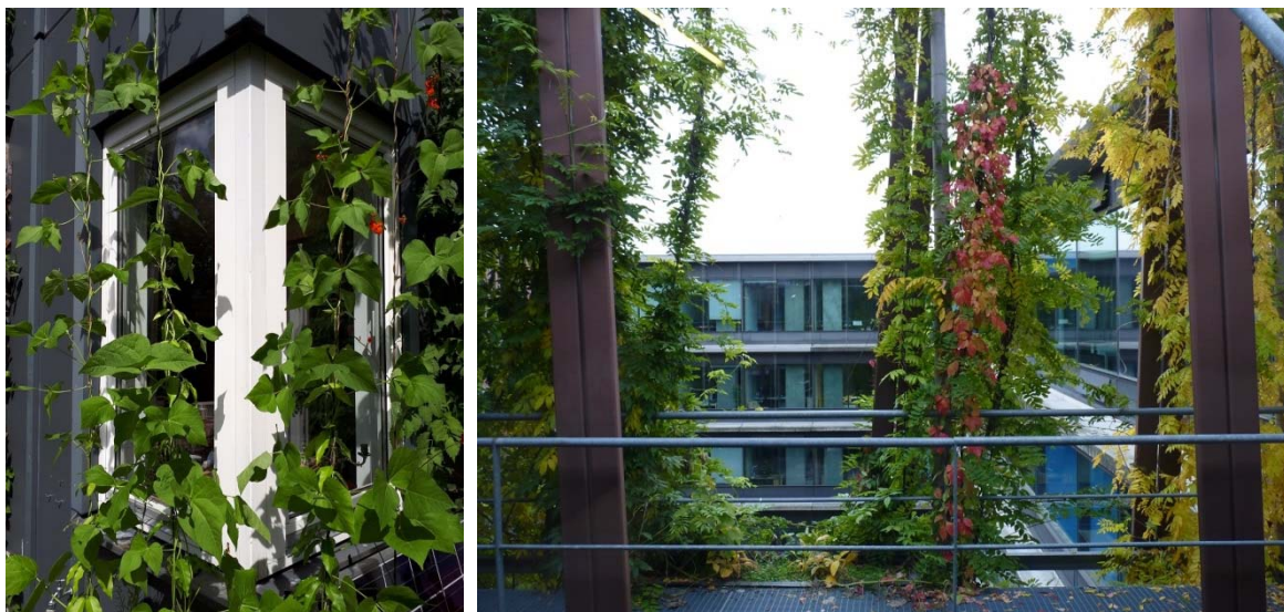
Abb. 4: An Seilen geführte Kletterpflanzen vor Glasfassaden bilden eine Synergie von Verschattung und Verdunstungskälte im Sommer, im Winter lassen Sie die Sonne ungehindert passieren.
