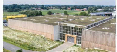
1 ha Biodiversitätsgründach auf einem Logistikzentrum der Firma Friedrich Lütvogt GmbH & Co. KG in Wagenfeld (Foto: Steffen Spitzner, Rechte: Friedrich Lütvogt GmbH & Co. KG)
