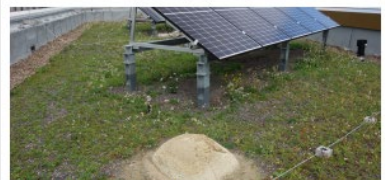
440 m² Dachbegrünung kombiniert mit Photovoltaik auf einem Gebäude der GEWOBA AG in Bremen
