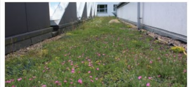
500 m² Gründach auf einem Hörsaalgebäude der Hochschule Osnabrück
