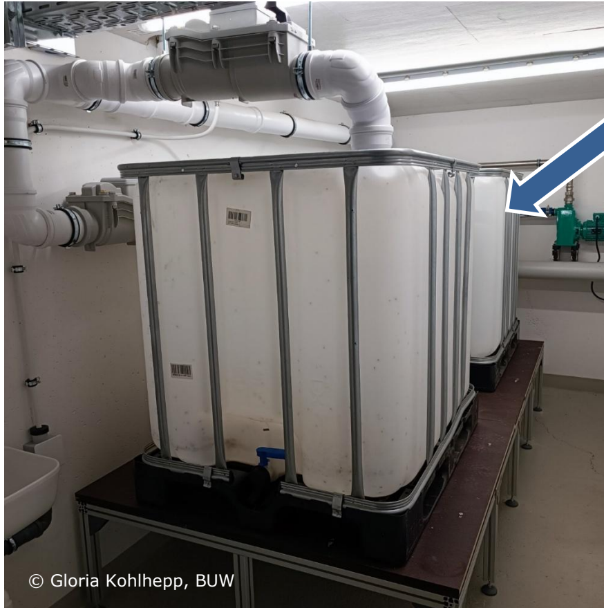
Absetz- und Entnahmetank in Weimar Schöndorf.
