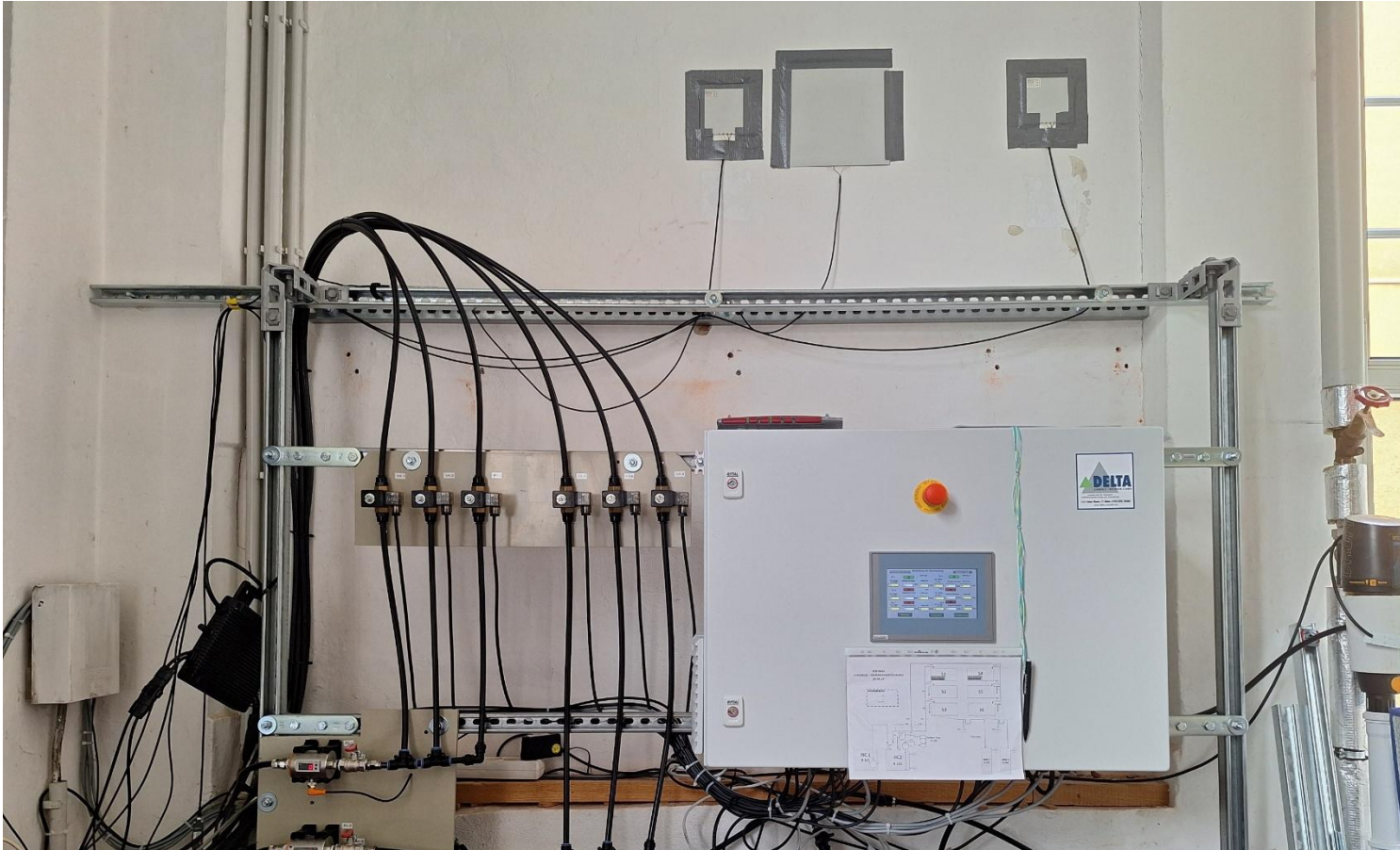
Steuerungsraum mit wandbefestigten Wärmeflussplatten.
