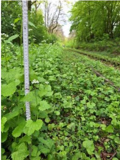
Reduktion der Wuchshöhe auf ca. 20 cm (Schienenoberkante).
